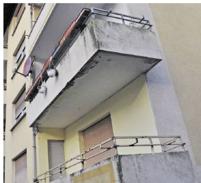
Die Balkone in der Siedlung Hirtenweg sollen saniert werden.
